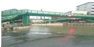
ゲリラ豪雨で冠水する府道139号線(7/9撮影)
